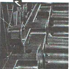
W przypadku budowania konstrukcji wielowarstwowych łączniki zapobiegają przesuwnemu się segmentów podstawowych
